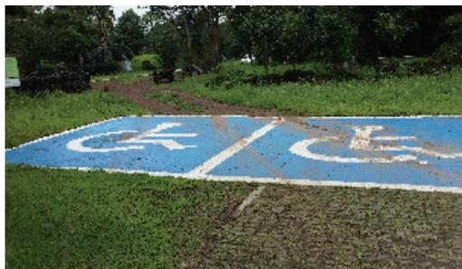
[그림22] 휠체어 이용이 불편한 주접근로-1 [그림23] 휠체어 이용이 불편한 주접근로-2
