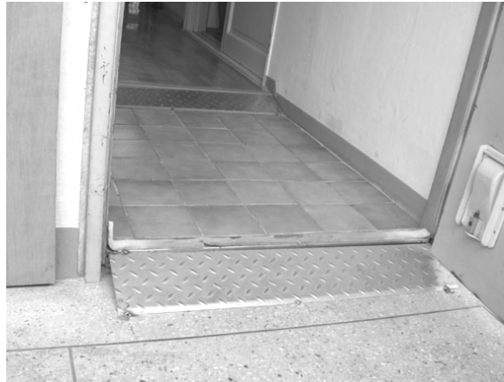
경사로 설치 후
