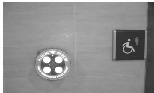
[그림 12] 비상상황 대비를 위한 '시민의 비상벨' 설치
