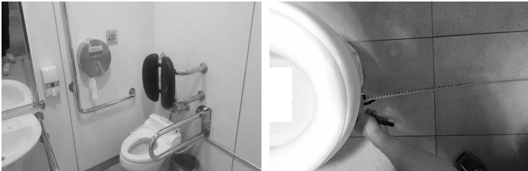
[그림 10, 11] 전면 활동공간(1.4m×1.4m)이 확보되지 않은 대변기
