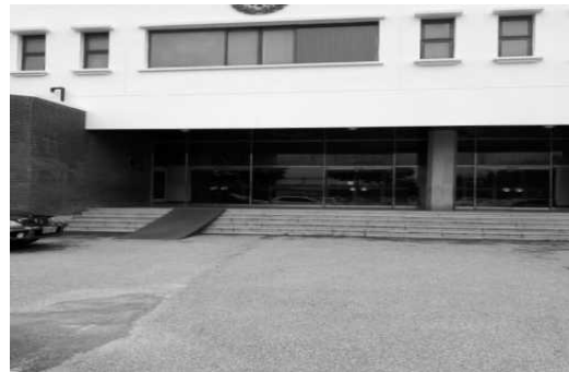
[그림 22] 주출입구에 계단 설치로 휠체어 사용자의 접근성이 낮으며, 경사가 가파른 임시 경사로 설치
