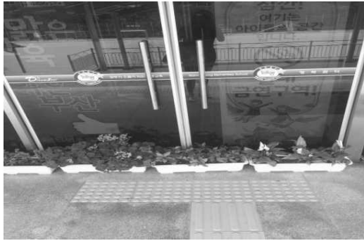
[그림 7] 단차가 제거되어 있지 않은 주출입구 [그림 8] 사용하지 않는 출입문 앞의 점형블록
