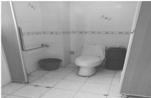
[그림 17] 회전식 손잡이가 미설치되고 청소용품이 적재된 장애인용 화장실
