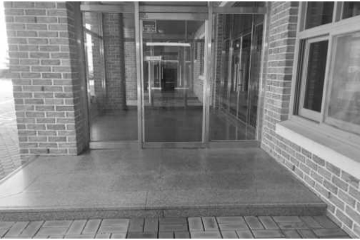
[그림 7] 단차가 제거되어 있지 않은 주출입구 [그림 8] 사용하지 않는 출입문 앞의 점형블록
