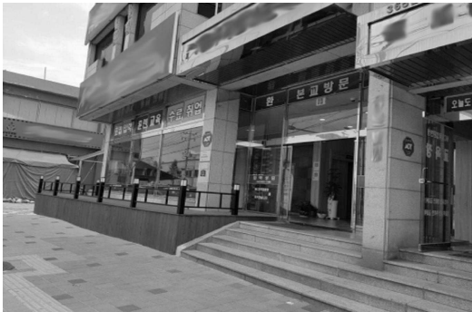
[그림 3] 계단만 설치되었고 별도 경사로가 없어 [그림 4] 주출입문의 문폭만큼 설치되지 않은 점형블록
