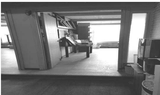
[그림 13] 단차가 높아 휠체어 사용 장애인의 접근성이 낮은 강의실
