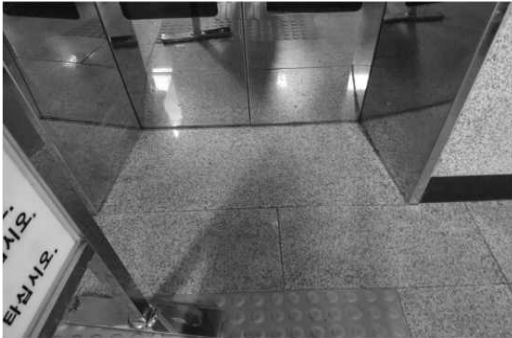
[그림 1] 엘리베이터 호출버튼 전면에 설치되지 않은 점형블록
