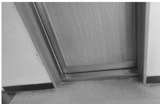
[그림 19] 단차가 있어 휠체어 사용자의 접근성이 낮은 교실 문
