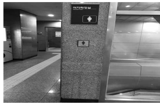
[그림 9] 설치되어 있으나 적정 높이(1.5m)가 맞지 않는 점자표지판
