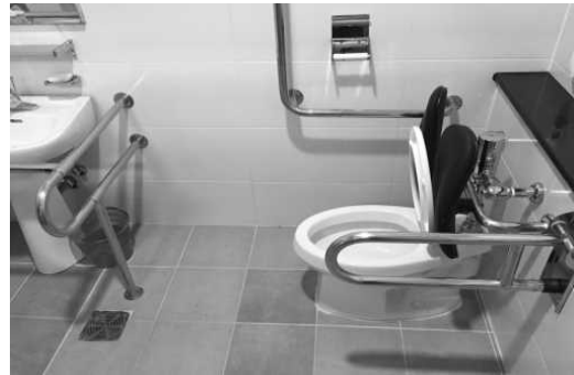
[그림 18] 대변기의 전면 활동공간 (1.4m×1.4m)이 확보되지 않는 장애인용 화장실
