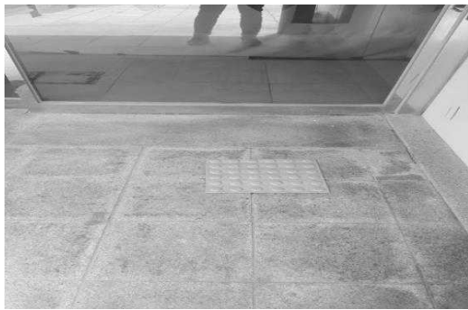
[그림 3] 계단만 설치되었고 별도 경사로가 없어 [그림 4] 주출입문의 문폭만큼 설치되지 않은 점형블록
