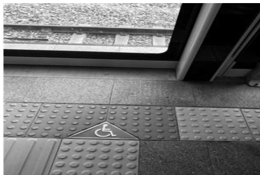
[그림 17] 바닥에 눈에 띄지 않게 설치된 휠체어 사용자 탑승 구역 안내표지
