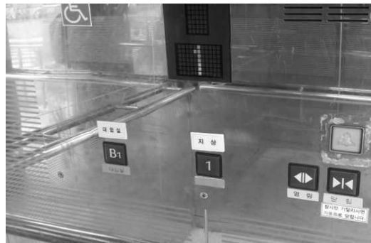
[그림 2] 점자표지가 미설치된 휠체어 사용자형 가로형조작반
