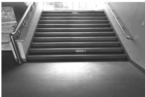
[그림 12] 계단의 시작과 끝 전면에 점형블록 미설치
