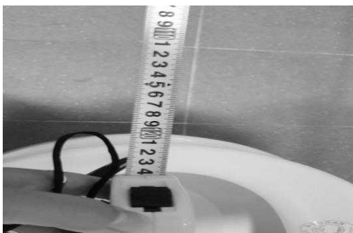
[그림 15] 전면 활동공간(1.4m×1.4m)이 확보되지 않은 대변기
