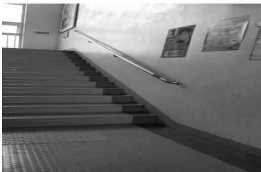
[그림 11] 계단 손잡이 끝부분의 점자표지판 설치 및 시작과 끝 전면에 점형블록 설치
