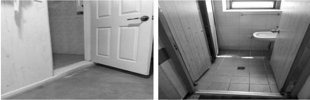
[그림 9, 10] 단차가 있어 휠체어 사용 장애인이 접근하기 어려운 화장실
