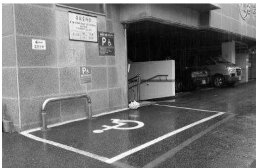
[그림 1] 직업교육훈련기관 건물 내 별도로 설치된 장애인 주차구역
