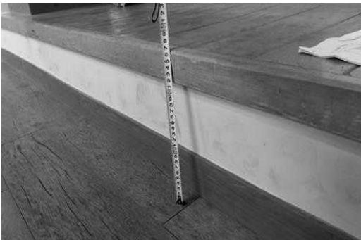
[그림 21] 단차가 있어 휠체어 사용자의 접근성이 낮은 도서관 문
