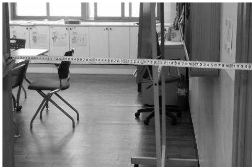
[그림 20] 통과 유효폭이 0.7m로 좁아 접근성이 낮은 교실 문
