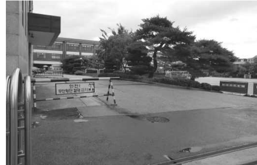
[그림 6] 보행통로의 구분이 없으며 안전선도 표기되어 있지 않아 안전성 미확보
