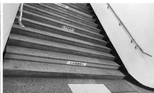
[그림 8] 계단의 시작과 끝 지점 전면 일부구역에만 설치되어 있는 점형블록
