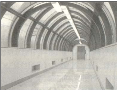
* 역사 뒤편을 이용한 휠체어 통로
