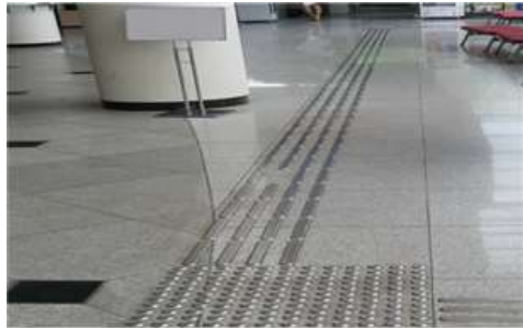
▶ 공연장 내부 tactile paving
