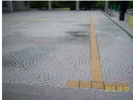
▶보완공사 #2-공연동과 문화동 입구측 광장점형블럭 설치
