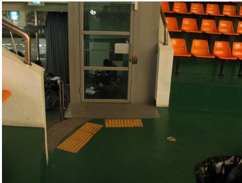
▶ 2층 관람석 수직 리프트 설치
