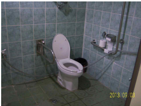
▶보완공사 #3-장애인 화장실 개조공사
