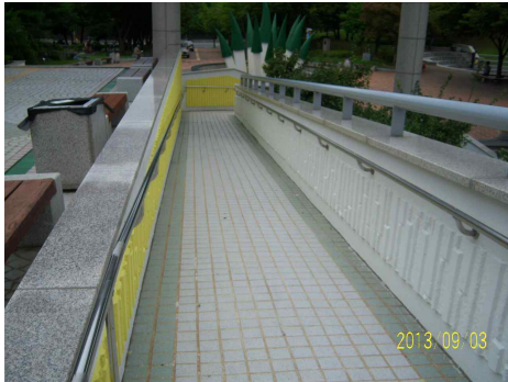
▶보완공사 #1-경사로 손잡이 설치
