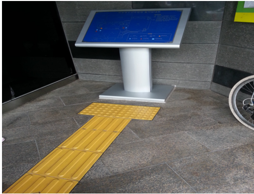
△ 주출입구 점자 및 촉지도식 안내판 설치
