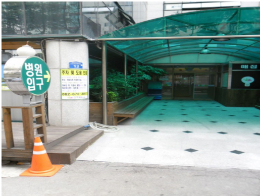
▲ 주출입구 앞 점형블럭 미설치
