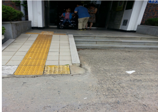
△ 주출입구 경사로 설치
