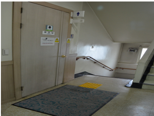
▲ 장애인화장실 앞 점형블럭 위 깔판 설치
