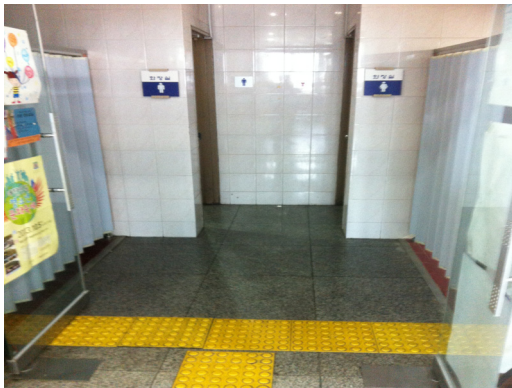
△ 화장실 앞 점형블럭 설치
