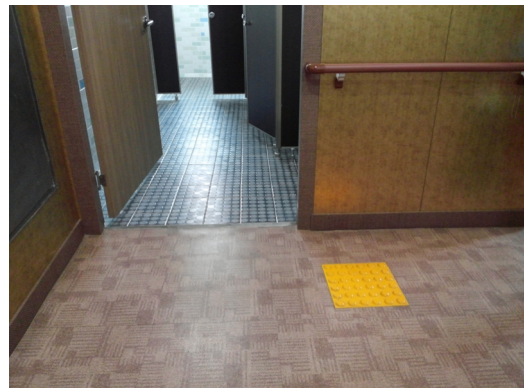
△ 장애인화장실 앞 점형블럭 설치
