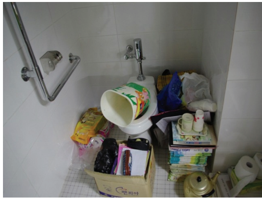
▲ 화장실 내 짐을 적재해 놓음(창고로 사용).
