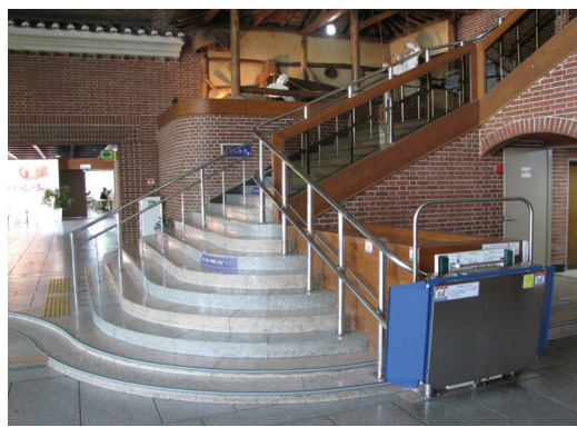
▲ 2층 전시실로 이동하기 위한 엘리베이터 미설치, 또한 설치된 휠체어 리프트도 무게제한으로 인해 전동휠체어나 스쿠터는 이용 불가능.
