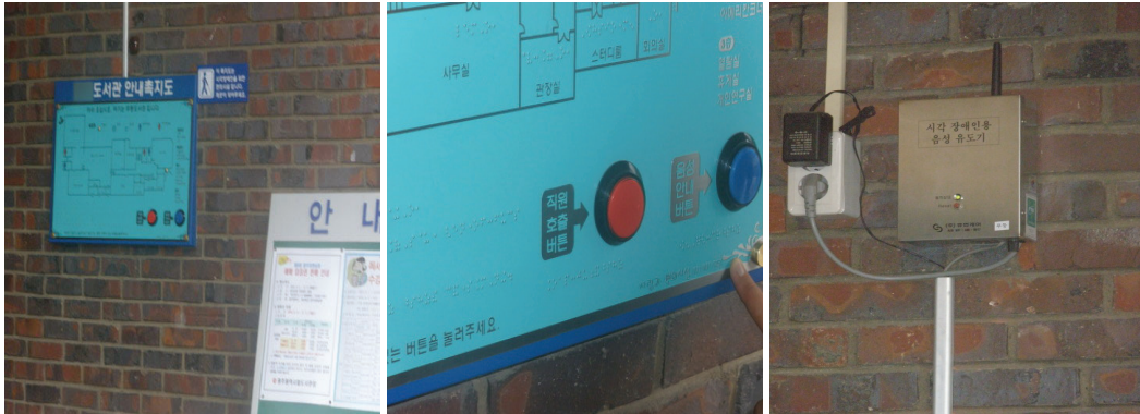
▲ 경사로 진입시 도서관 안내촉지도, 직원호출버튼과 시각장애인용 음성안내버튼 설치(모범사례).
