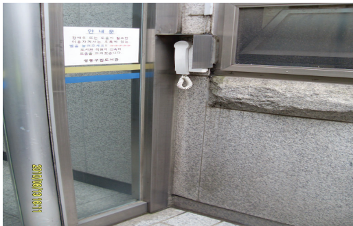
▲ 출입문에 호출기가 있으나 점자표시가 없고, 휠체어에 앉아서 사용할 수 없는 위치에 설치되어 있음.
